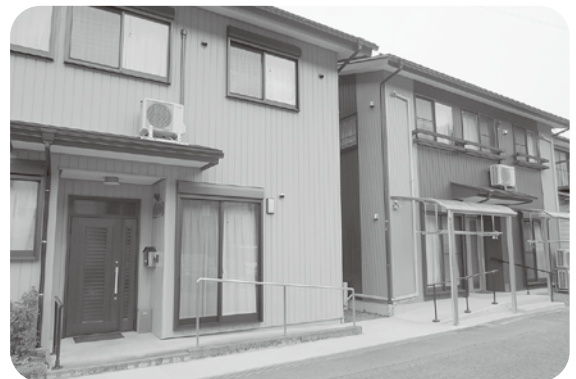
▲グループホームの前に手すりを設置
